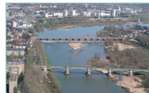
Resserrement et encombrement du lit de la Loire.
