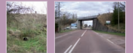
Deux des dix ouvertures dans le remblais SNCF qu'il faudrait fermer pour éviter l'inondation par remous.
