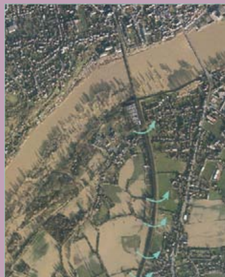
Passages dans le remblai SNCF. Crue de décembre 2003 - Photo APEI.
