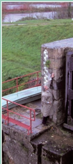
Une échelle de crue mesure la hauteur d'eau dans la rivière.
