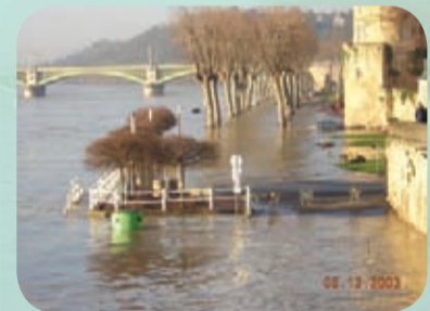
Décembre 2003 Écrêtement par Villerest : 1 300 m³/s. Débit à Nevers : 2 180 m³/s.
