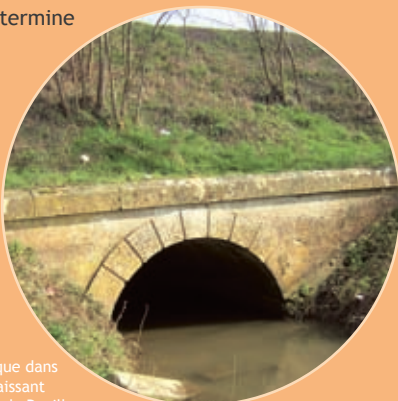
Pont-canal comportant un seuil à son pied
