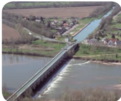
Le Pont-Canal du Guétin sur l'Allier
