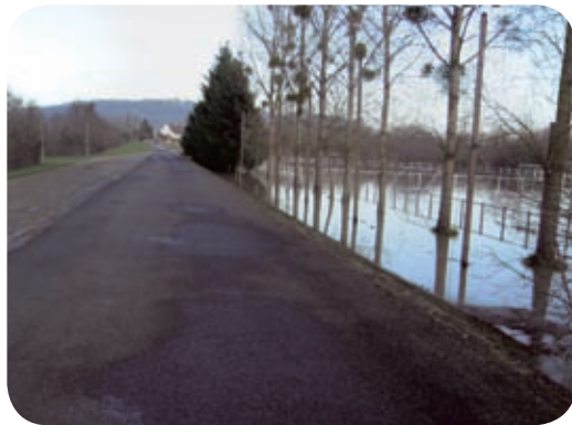
Le déversoir du Guétin à la confluence Loire-Allier
