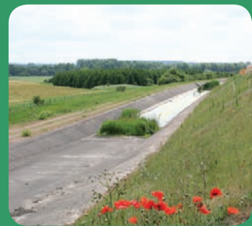
Bassin maçonné le long de l'A 77. Le chenal de décharge serait beaucoup plus important
