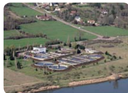
Station d'épuration de Nevers
