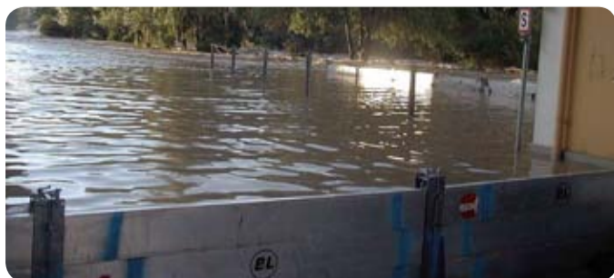
Des protections amovibles peuvent réduire l'impact des crues. Photo MSEI Environnement.
