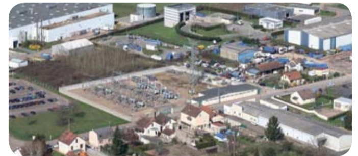
Le poste électrique source de Nevers-est est inondable. Intervenir sur les réseaux est une priorité car leurs dysfonctionnements peuvent perturber l'ensemble de l'agglomération.
