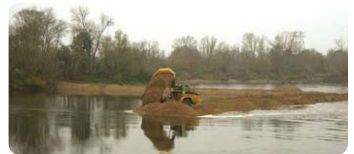
Restauration du lit devant Fourchambault. Lors de ces opérations, il faut remettre les sédiments dans le lit. Une incertitude perdure quant à la durabilité des opérations de restauration.
