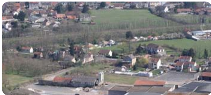
La fermeture des passages dans le remblai ferroviaire soustrait les enjeux des crues les plus fréquentes, jusqu'à T = 170 ans au maximum.
