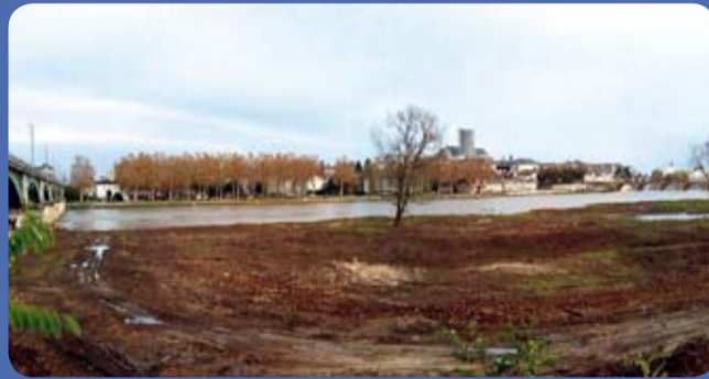
Travaux d'entretien entre les deux ponts de Nevers réalisés en 2013
