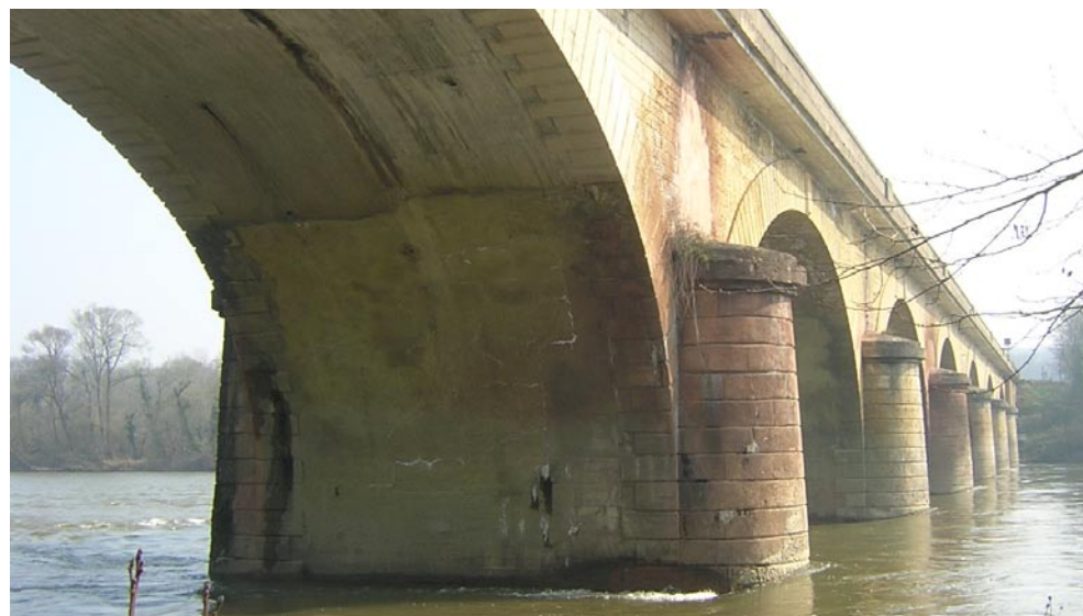
Pont SNCF d'Appremont (PK1004,083)
