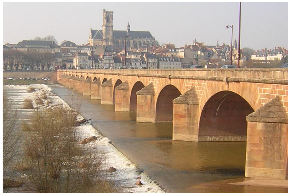
Pont de Nevers RN7 (PK1000)
