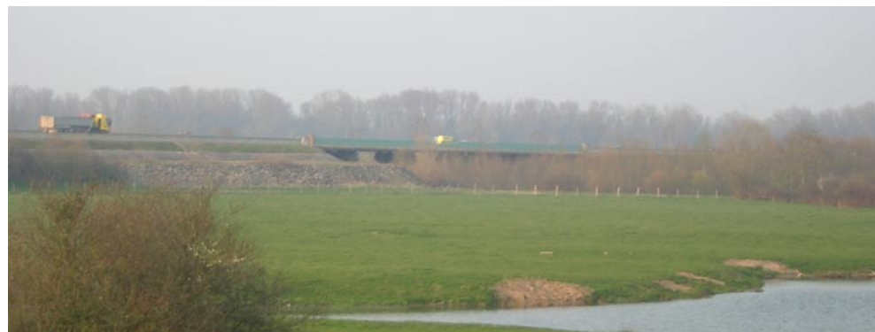
Pont de l'A77 (PK996,8)
