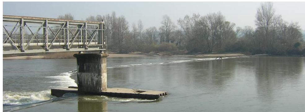
Barrage des Lorrains (PK1002,4)
