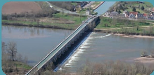
Le pont-canal du Guétin sur l'Allier
