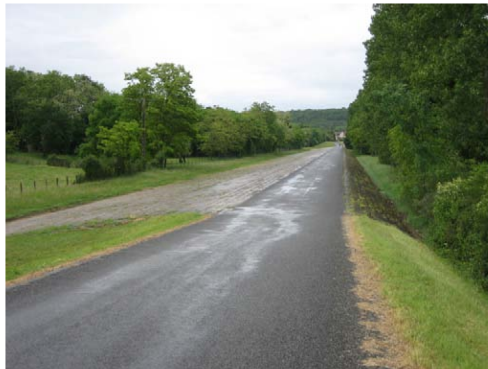
Le déversoir du Guétin au Bec d'Allier
