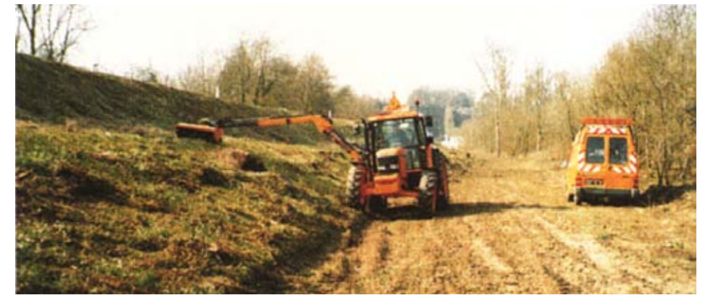
Travaux d'entretien des levées de la Loire
