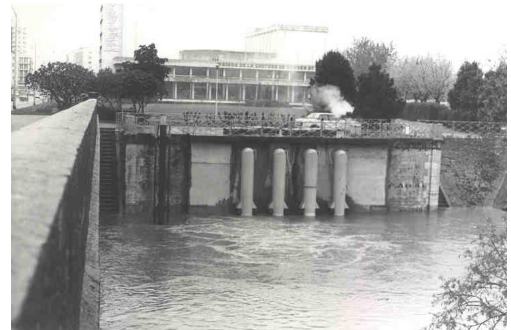
Station de pompage des eaux de la Nièvre lors de la crue de 1983
