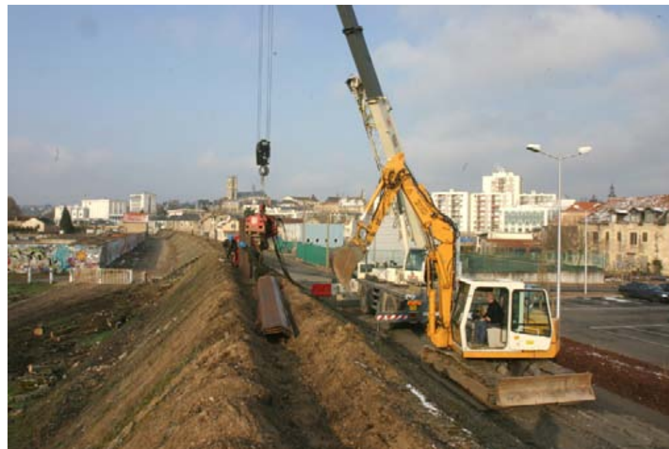
Mise en place de paplanches dans la levée de Saint-Eloi
