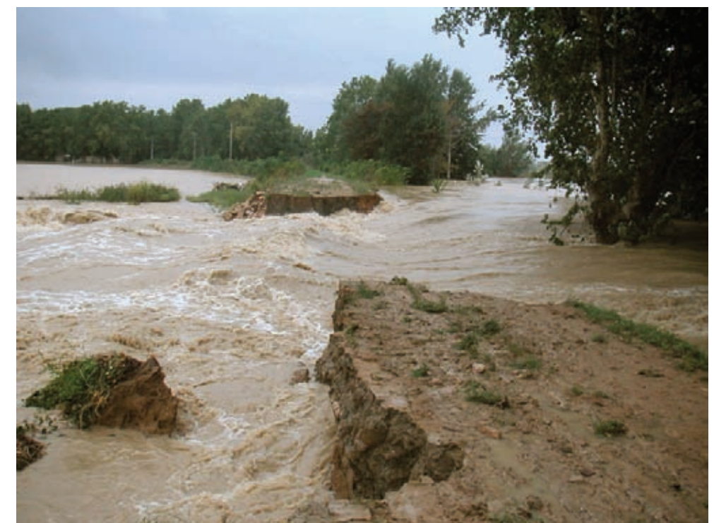
Brèche à Aimargues lors de la crue du Petit-Rhône en septembre 2002. Crédit photo : mairie d'Aimargues
