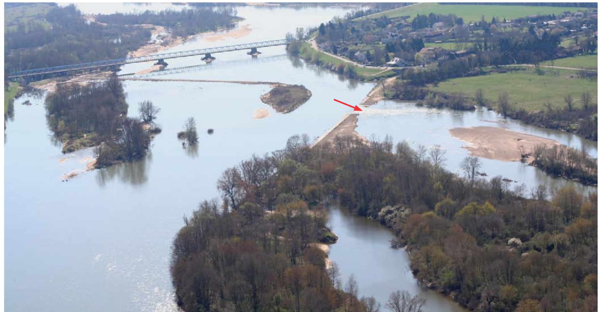
Travaux de restauration devant Fourchambault
