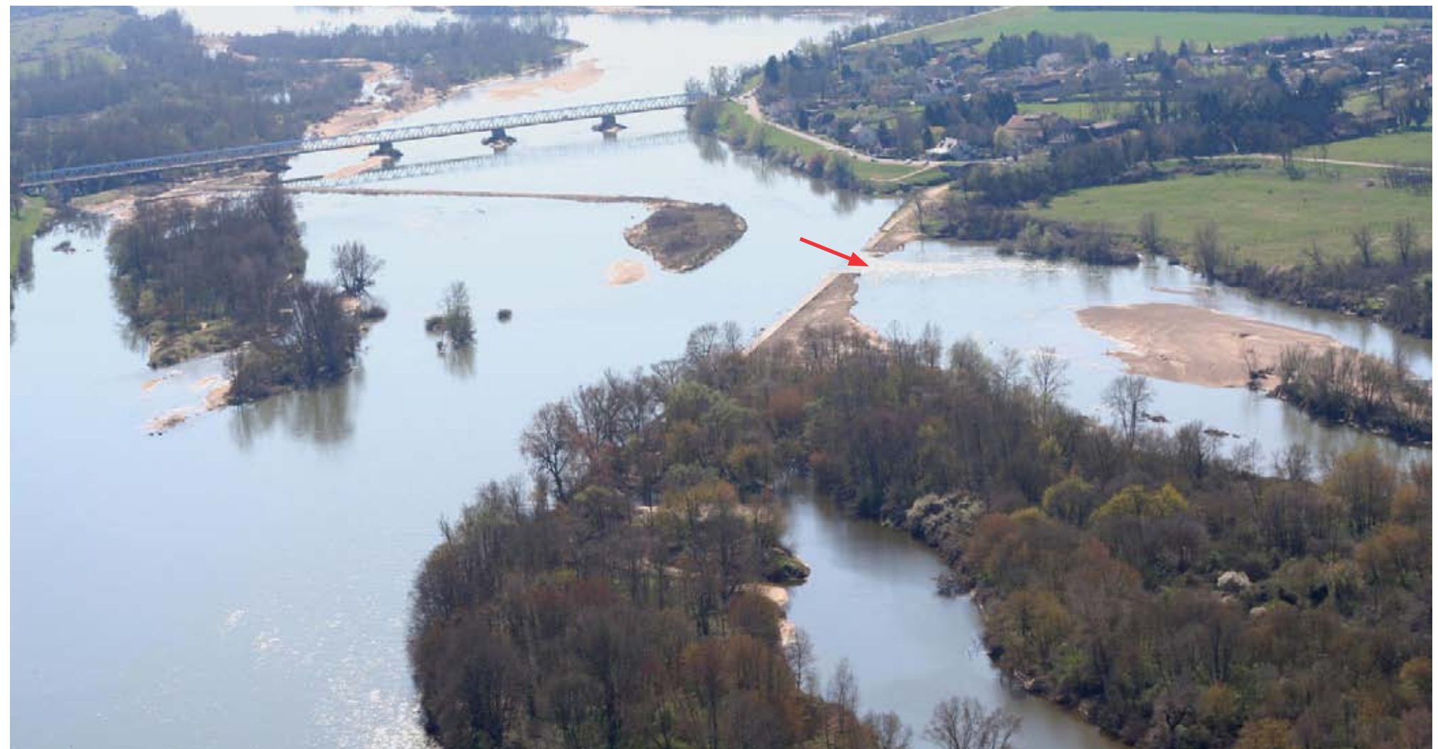
Travaux de restauration devant Fourchambault
