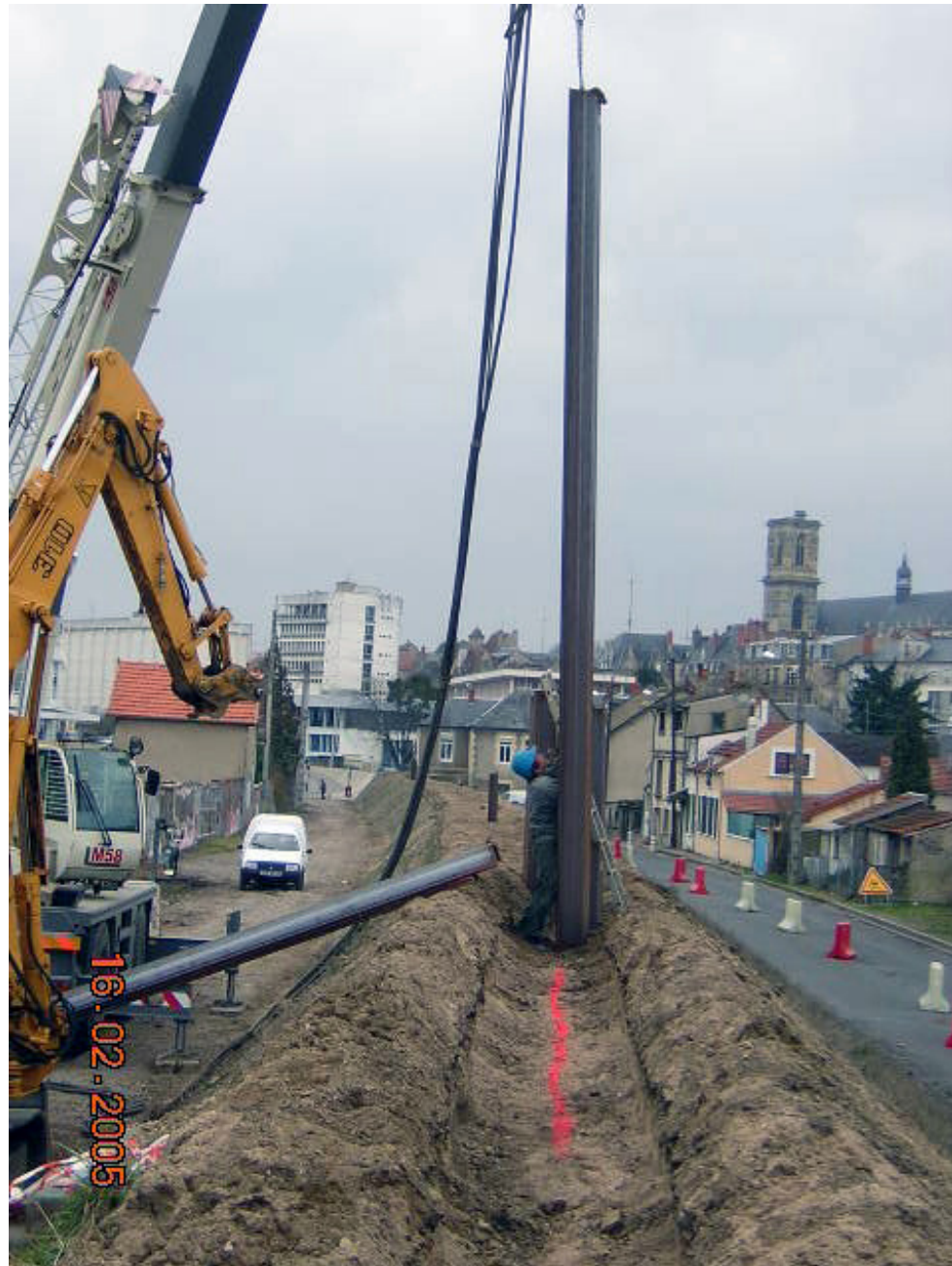
Mise en place de paplanches dans la levée de Saint-Eloi
